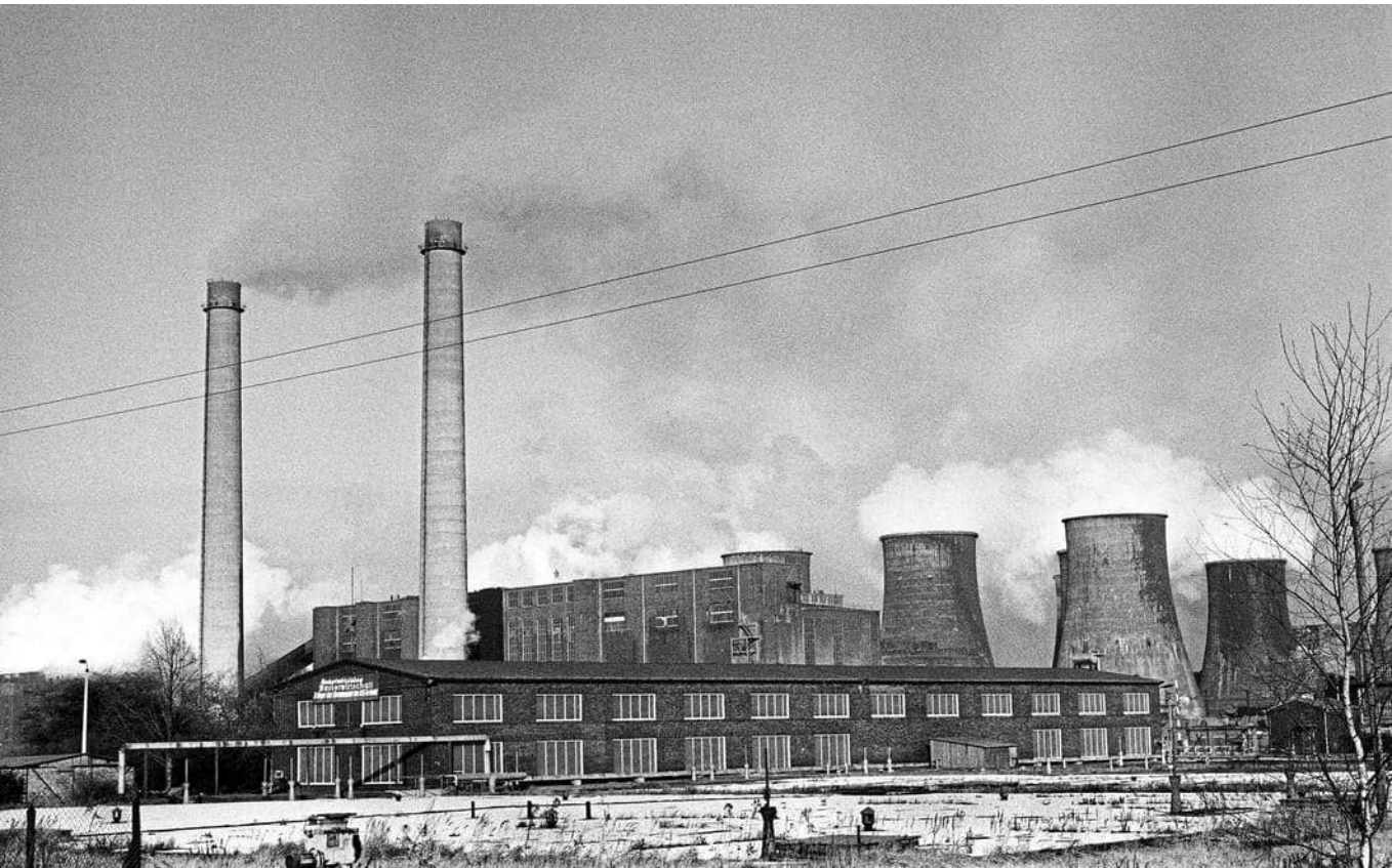
Januar 1990: Der VEB Kombinat Espenhain war ein Betrieb zur Gewinnung und Verarbeitung von Braunkohle.
